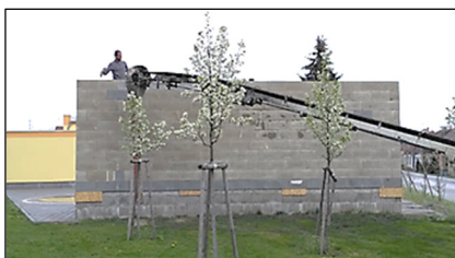
Foto: betonování pódia, autor: Stanislav Winter
