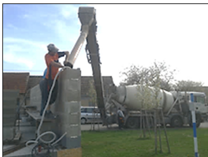
Foto: betonování pódia
