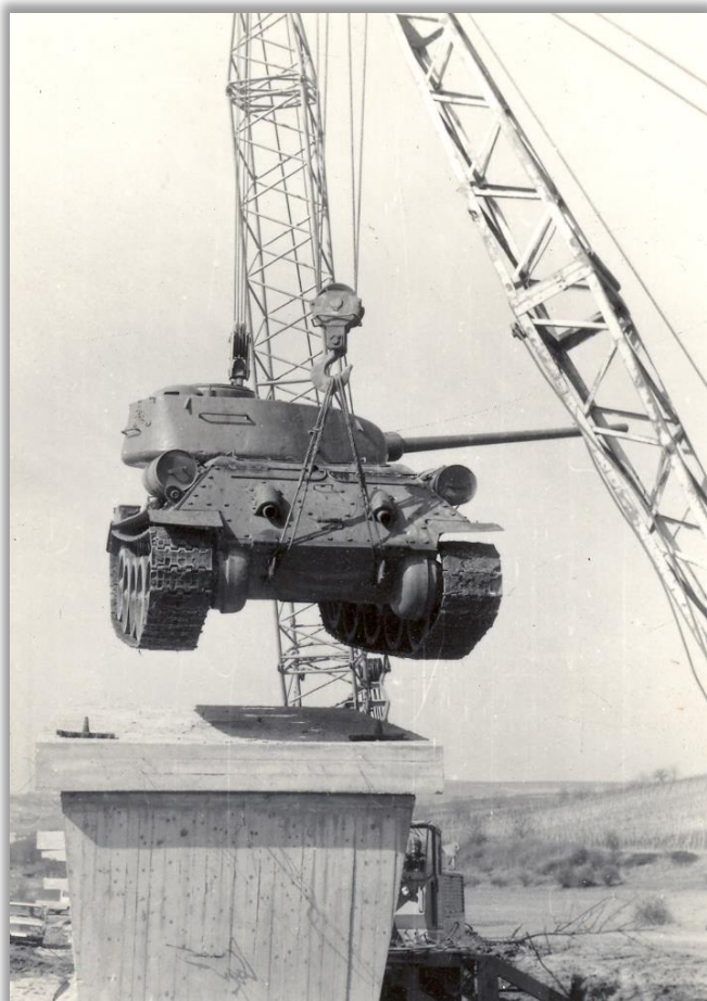
Výstavba památníku na jaře r. 1975
