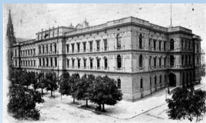
Budova Zemského sněmu v Brně, dnes his- toricky chráněná novorenesanční budova, sídlo Ústavního soudu, archiv autora
