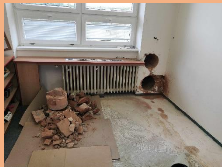
Vzduchotechnika ZŠ - stavební práce
