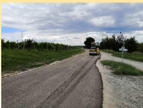
Oprava cyklostezky Nové hory
