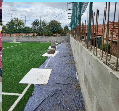
◀ Sportovní areál ▼ Stavba akustické stěny víceúčelového hřiště (foto: VD)
