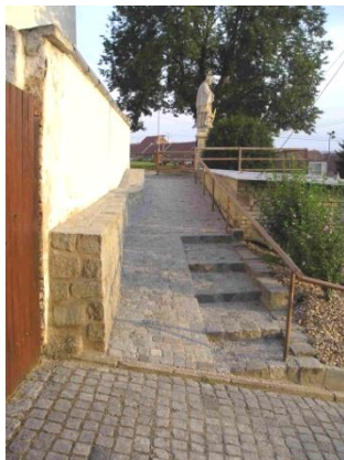
foto: opravený chodník u kostela
