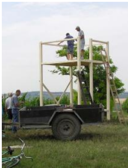
Do konce června bude dokončena stavba vyhlídky U Obrázku.
