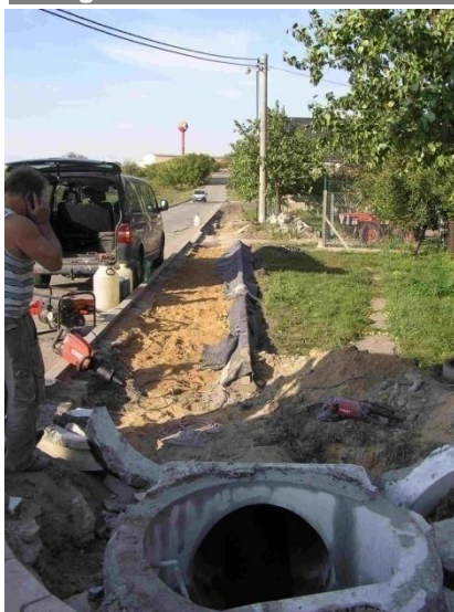
foto: budování chodníku na Objížďce
