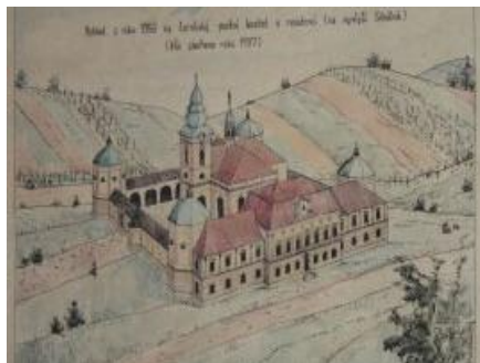
Žarošický poutní kostel s rezidencí z r.1760
