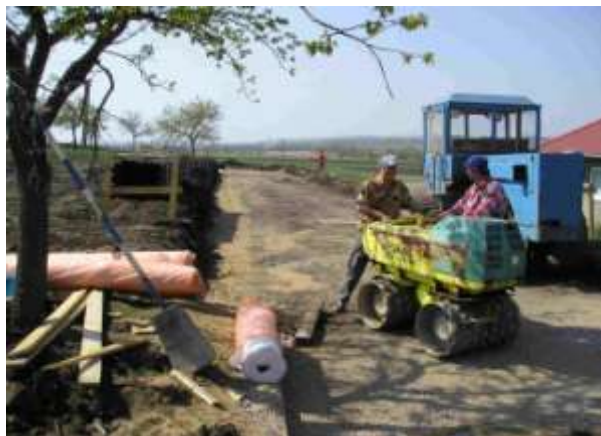
foto: výstavba nové komunikace Tálky III.
