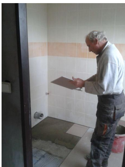
foto: stavební úpravy ubytovny
