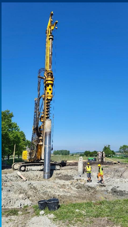
FOTO: Stavební práce na ČOV
